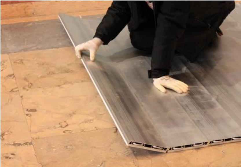
Vengono posate le doghe, ogni dogha dispone già dell'isolante in cadorite (PVC espanso a celle chiuse) nella parte sottostante e della resistenza all'interno, nello specifico sono sprovviste di finitura, in quanto verrà posata successivamente.
